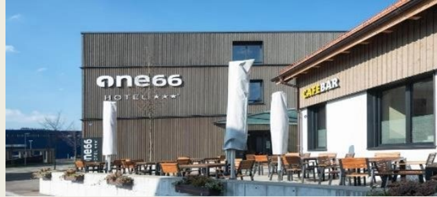
Hotel one66 Bildstrasse 6 9015 St.Gallen
